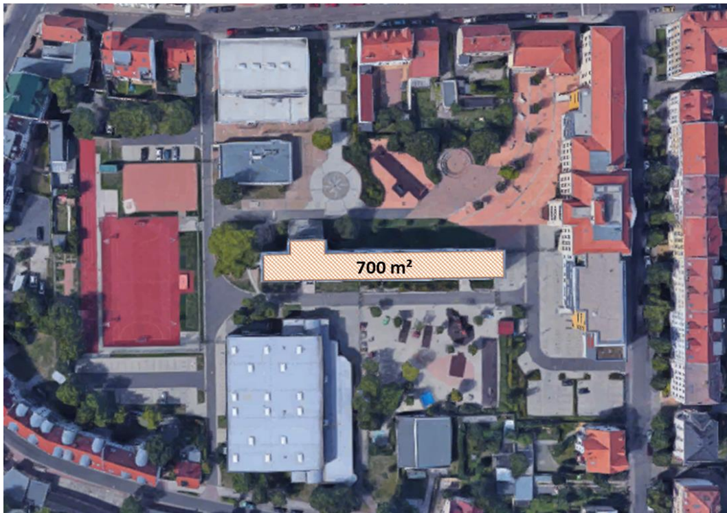
Abb. 17 Übersicht potenzielle Dachfläche für PV-Anlage der Grundschule Markkleeberg-West
